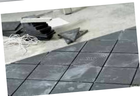
Klinkeopsætning og fliselægning
