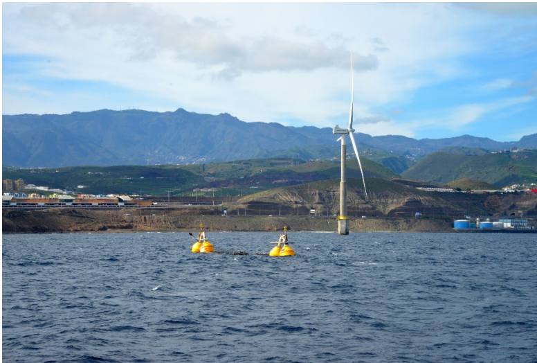
Figur 1: Wavepistons installation ved Gran Canaria
