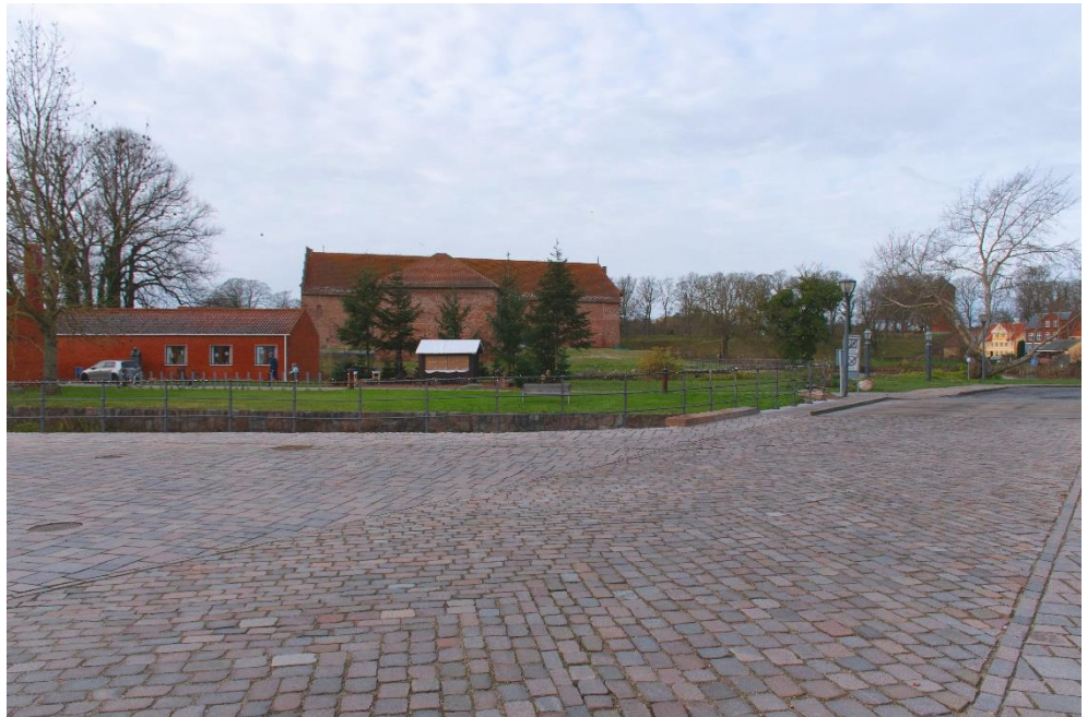
Figur 8-7 Nyborg Slot 2023 set fra Torvet. Biblioteket er den lave røde bygning til venstre. Foto COWI.
