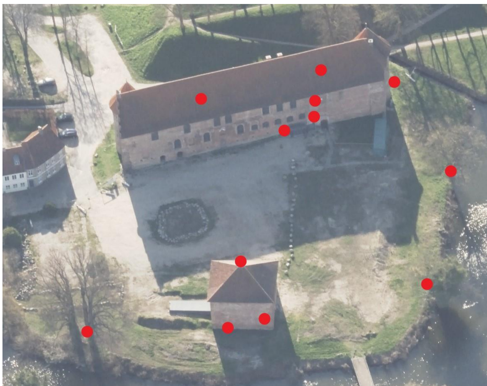
Figur 10-11 Skråfoto af Nyborg Slot samt markeringer (røde prikker) af, hvor der har været placeret automatiske lyttebokse. Markeringerne på bygningerne indikerer placeringen på hver etage i henholdsvis hovedbygningen og vagttårnet.
