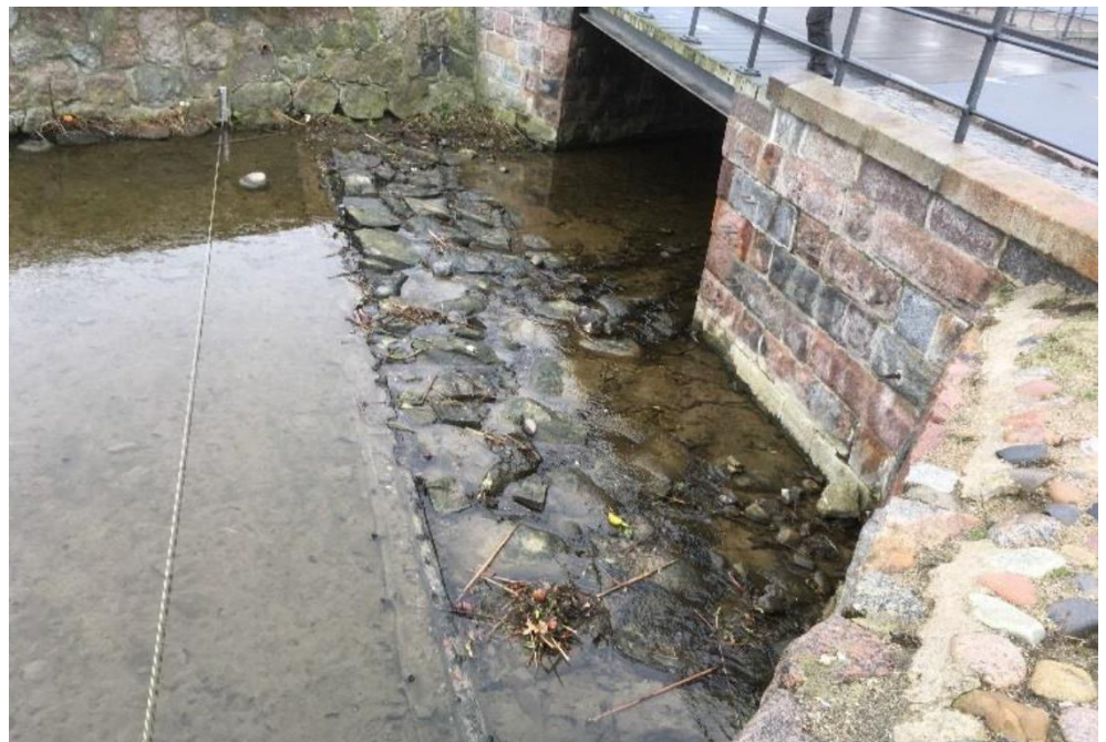
Figur 11-2 Opstemningskant i Voldgraven ved Torvet ved st. 1.264 m. Det er denne kant, der ønskes hævet med vandspejl til kote 3,75 m (Bangsgaard & Paludan ApS., 2019).
