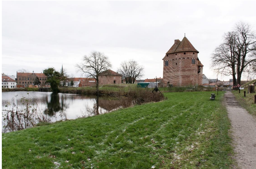
Figur 8-11 Nyborg Slot set fra nord på stien mellem Blegdamsgade og Slotsgade. COWI.
