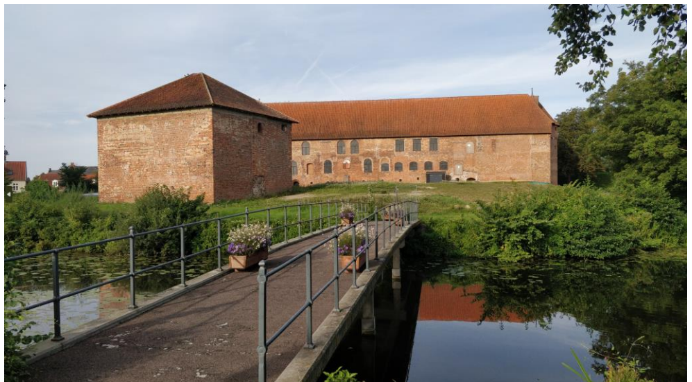
Figur 10-6 Slotsbroen set fra Biblioteksholmen mod Slotsholmen (foto fra besigtigelse).
