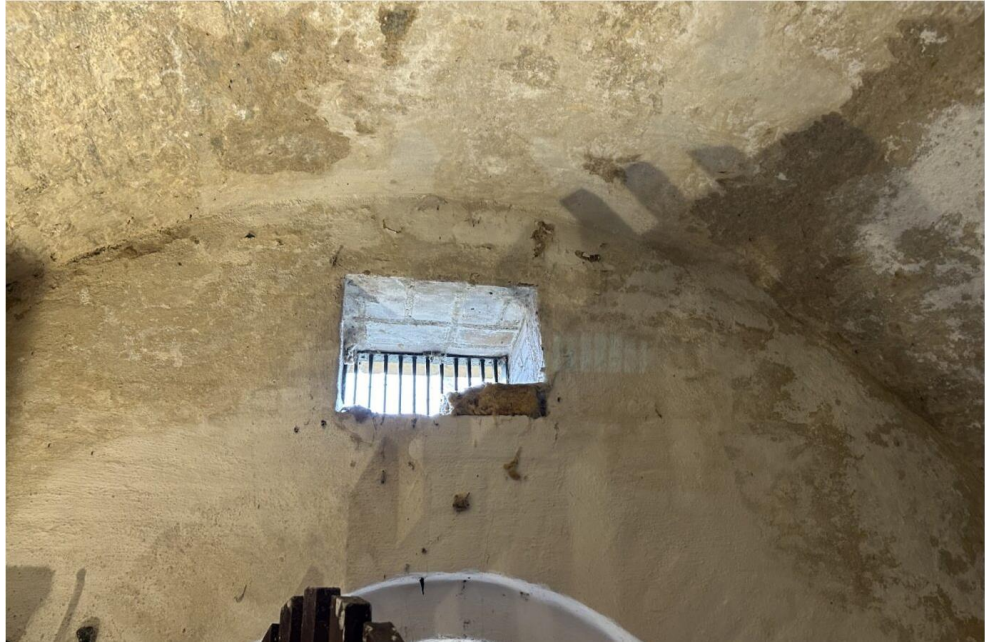
Figur 10-29 Egnest loftshvælvning og åbning der tillader adgang for flagermus i krudtmagasinet på Bastionen.
